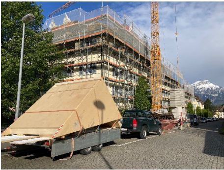
Anlieferung der vorgefertigten Holzelemente für die neuen Dachlukarnen.
