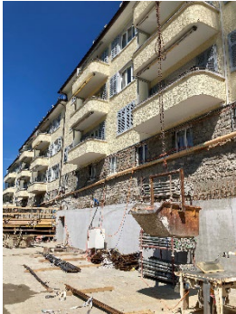
Einblick in die komplexe Baustelle
